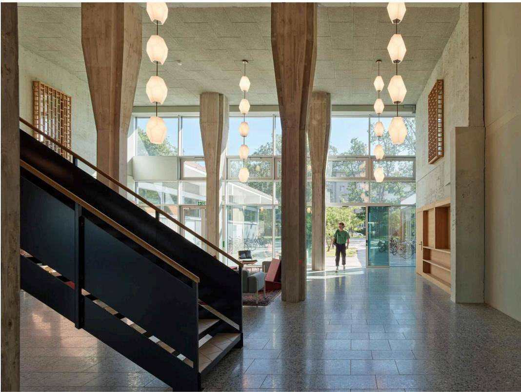
Foyer, Treffpunkt und öffentliche Querung. Die obere Ausweitung der Pfeiler ermöglichte das Einfüllen des Betons seitlich der direkt darüberliegenden, tragenden Wände. (Foto: Ariel Huber)
