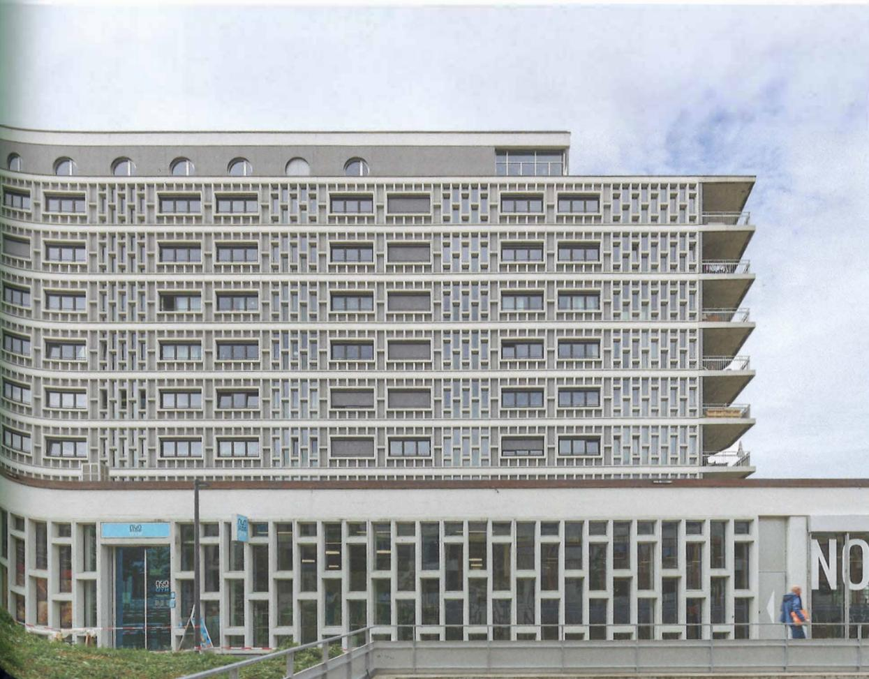
Blick auf die sanierte Nordfassade: Die Betonfertigteilelemente wurden gereinigt und teils instandgesetzt, die Holzrahmenfenster aus energetischen Gründen ausgetauscht.
