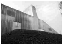
Kupferbahnen in traditioneller Falztechnik bilden die Fassade
